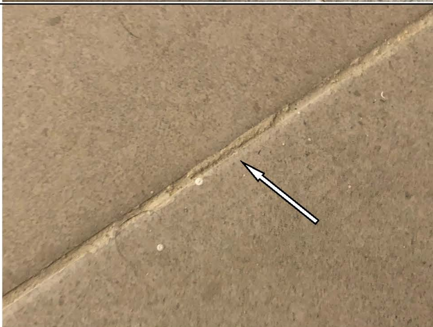
Фото №8. Неровный шов напольной плитки в кладовке в квартире.
