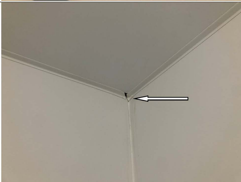
Фото №12. Дефект крепления гибкой вставки в ванной комнате в квартире.
