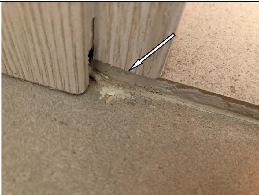
Фото №17. Не хватает наличника деревянного дверного блока до напольного покрытия в ванной комнате в квартире.
