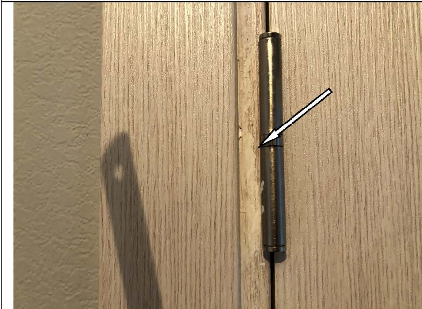
Фото №23. Загрязнения на наличнике деревянного дверного блока в ванной комнате в квартире.
