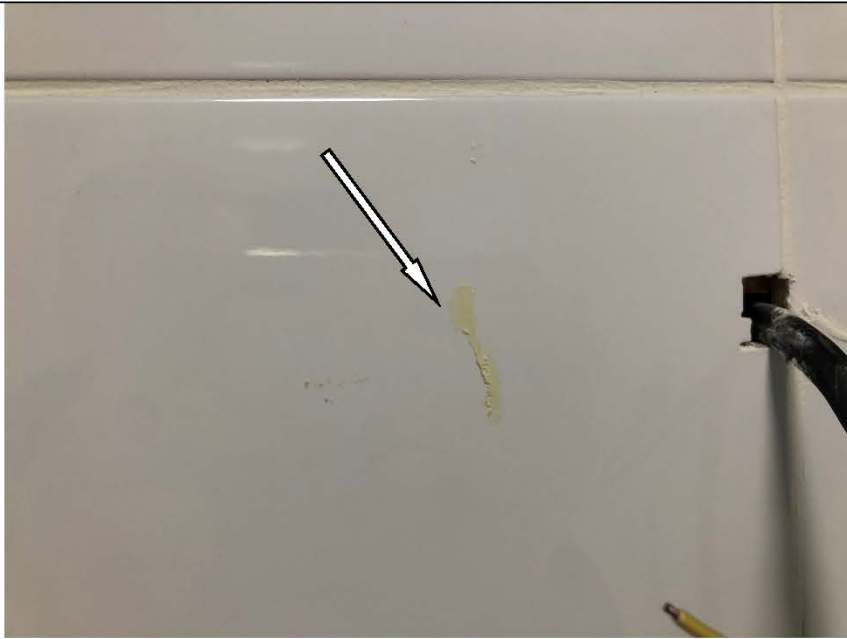
Фото №28. Загрязнения на настенной керамической плитке в ванной комнате в квартире.
