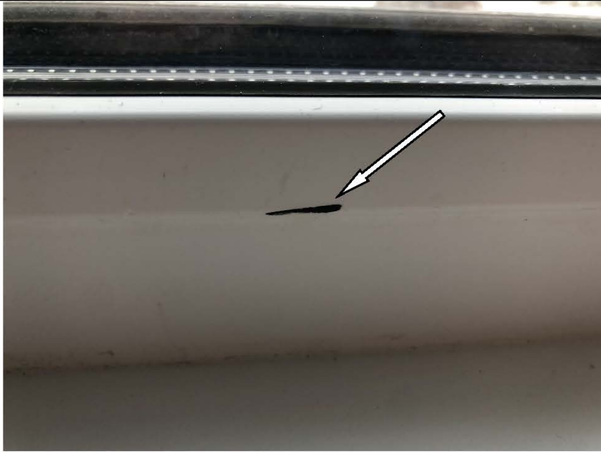
Фото №37. Загрязнения на профиле оконного блока ПВХ в кухне в квартире.
