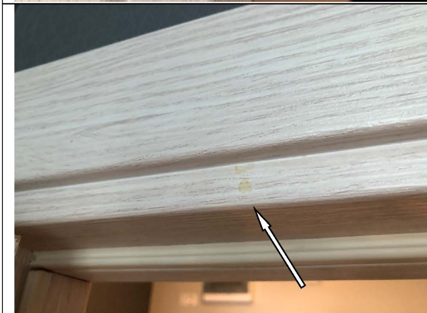
Фото №20. Загрязнения на коробке деревянного дверного блока в кухне в квартире.
