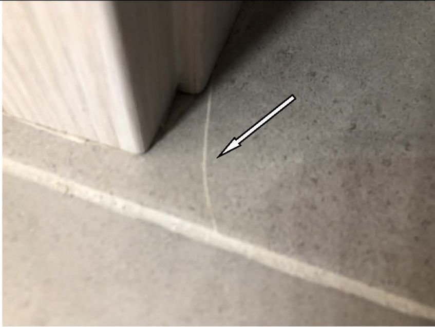
Фото №10. Трещина на напольной керамической плитке в кладовке в квартире.
