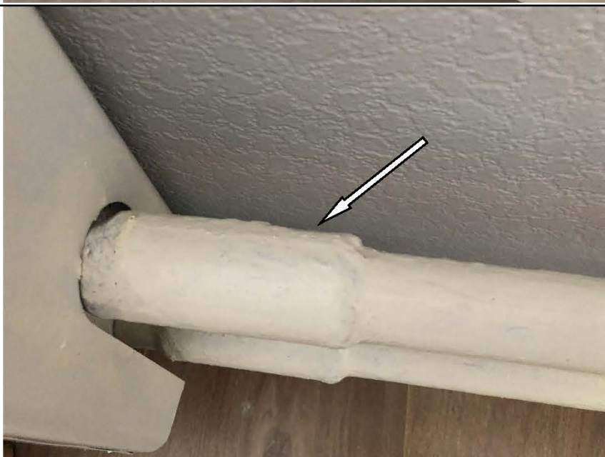
Фото №41. Неровности, сколы на окрашенных трубах отопления в спальне в квартире.
