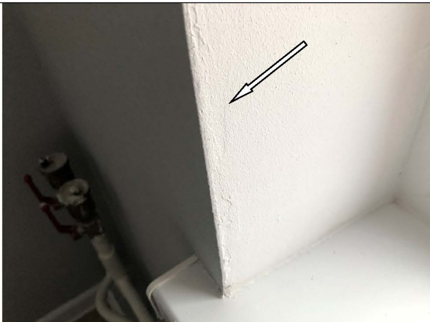
Фото №34. Неровности, сколы на окрашенных откосах оконного блока ПВХ в спальне в квартире.
