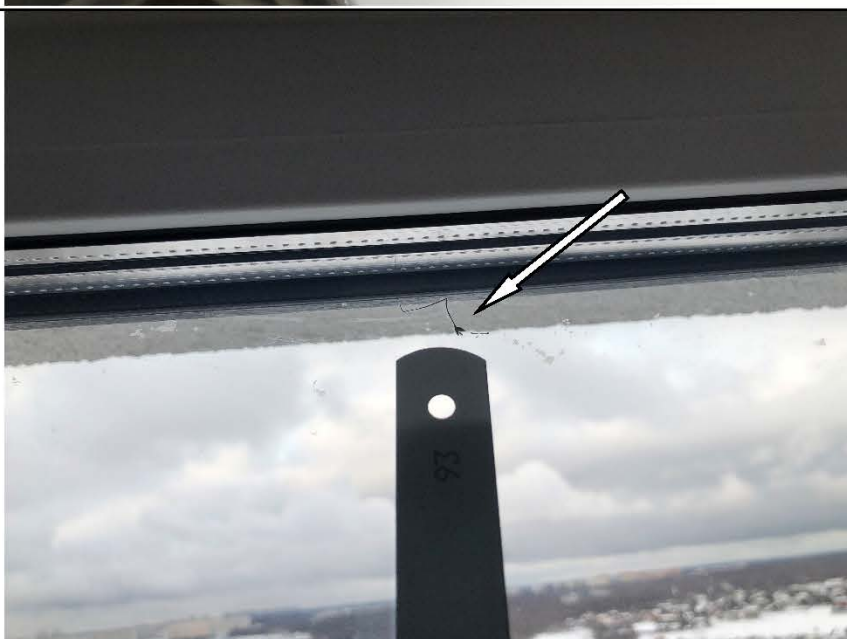
Фото №35. Окарины на стеклопакете оконного блока ПВХ в кухне в квартире.
