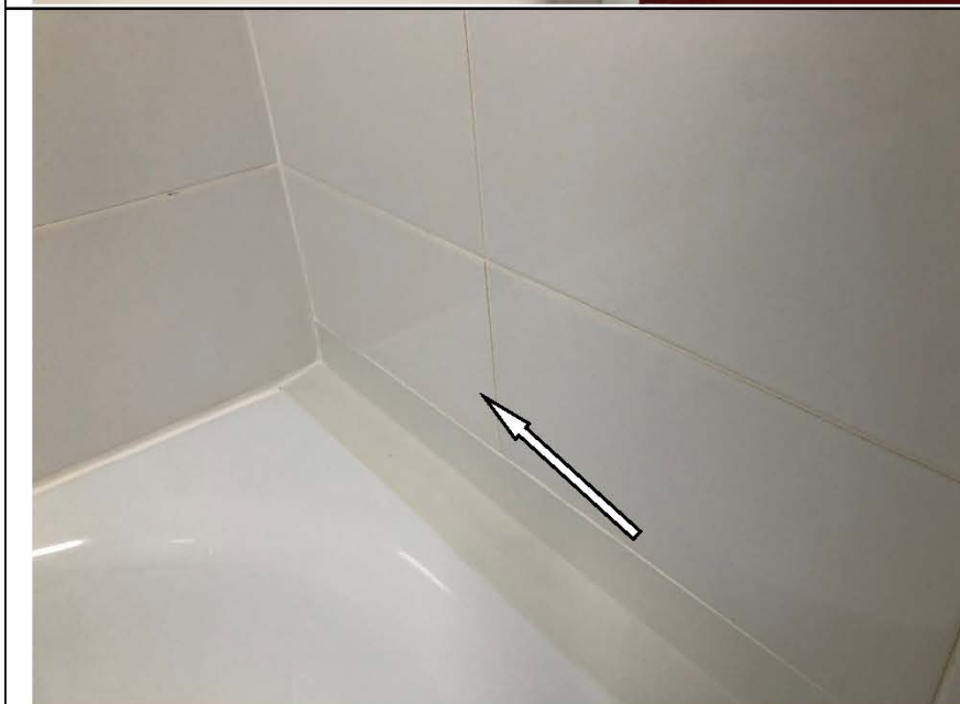
Фото №26. Разный цвет настенной керамической плитки в ванной комнате в квартире.
