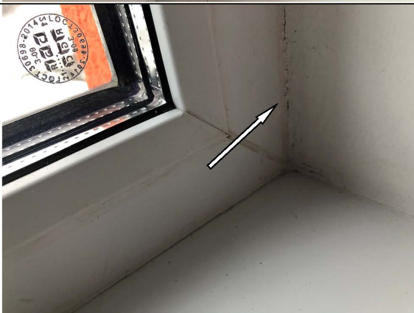
Фото №32. Инфильтрация оконного блока ПВХ в спальне в квартире.
