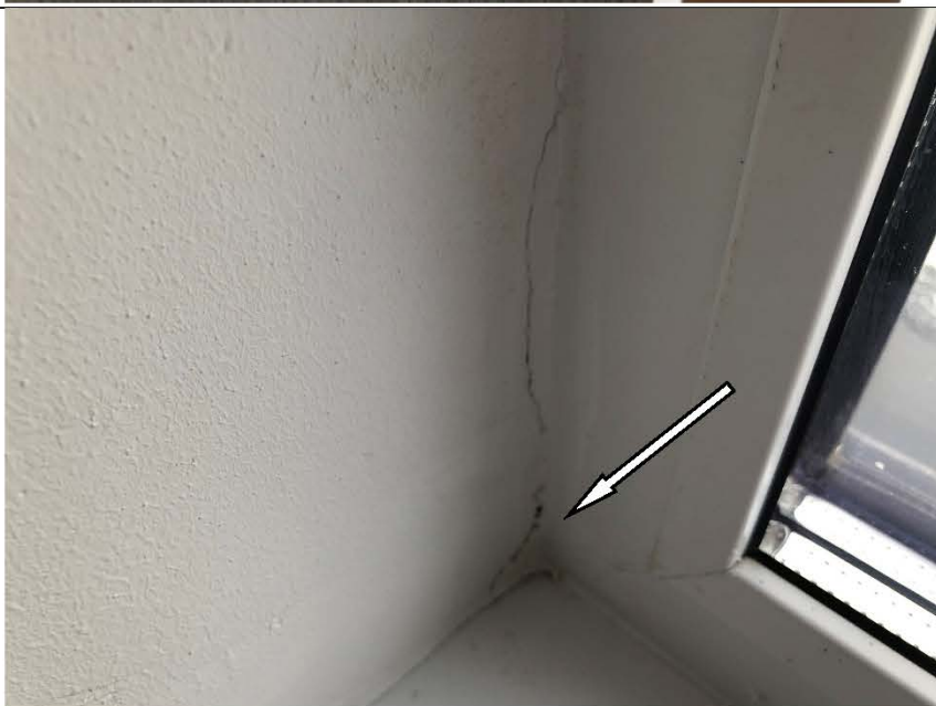
Фото №30. Инфильтрация оконного блока ПВХ в кухне в квартире.
