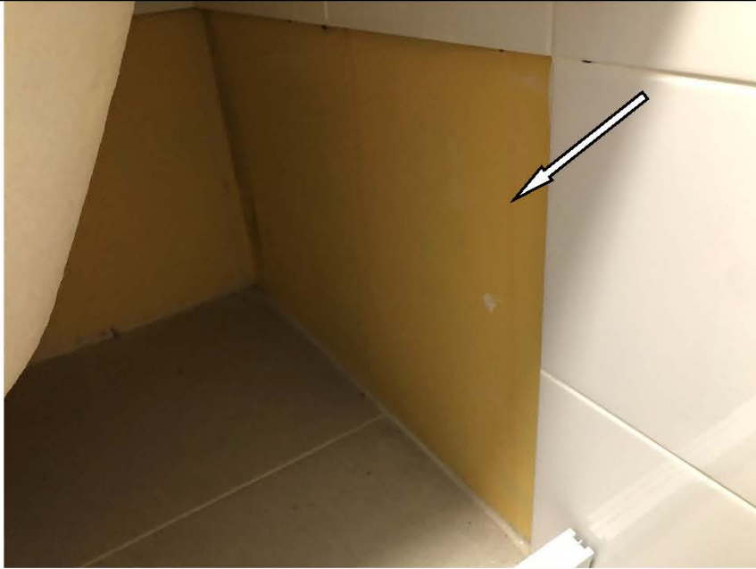
Фото №16. Частично не хватает настенной керамической плитки в ванной комнате в квартире.
