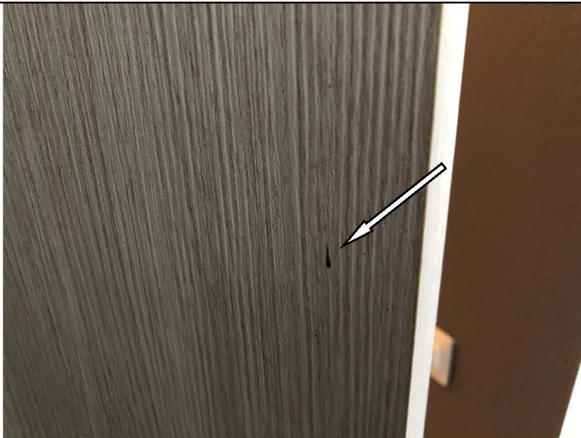
Фото №29. Загрязнение на полотне деревянного дверного блока в кухне в квартире.
