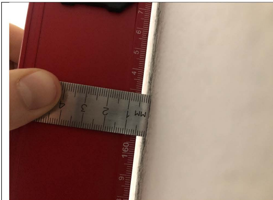
Фото №4. Измерение уровня стен кладовки в квартире.
