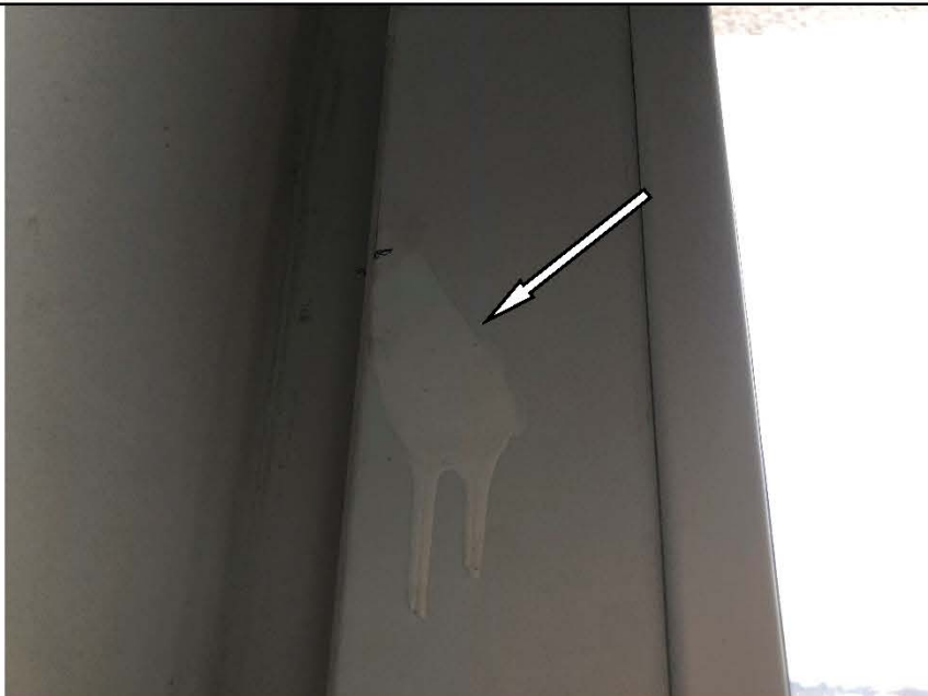
Фото №38. Загрязнения на профиле оконного блока ПВХ в спальне в квартире.
