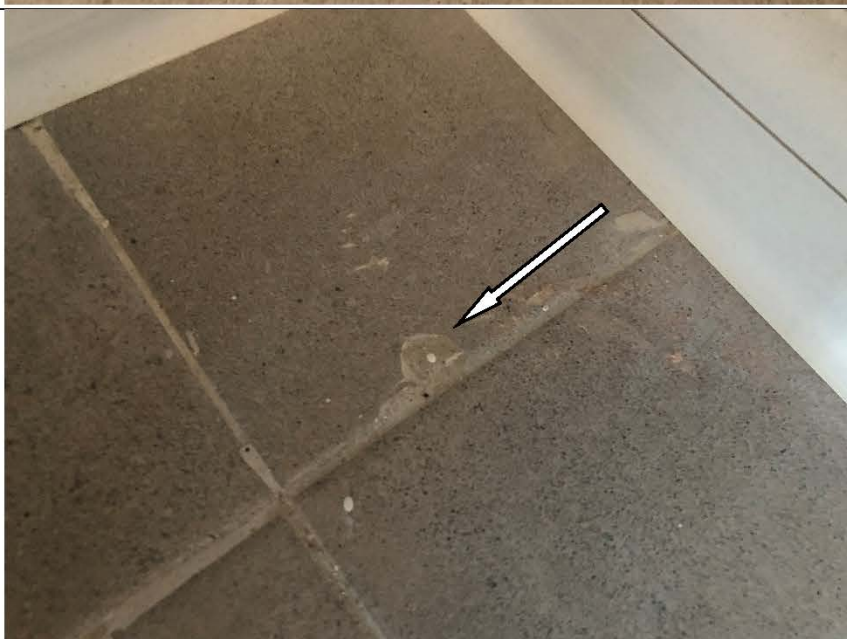
Фото №9. Скол на напольной керамической плитке в коридоре в квартире.
