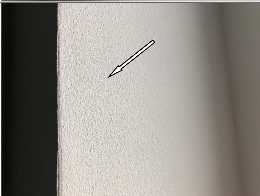
Фото №33. Неровности, сколы на окрашенных откосах оконного блока ПВХ в кухне в квартире.
