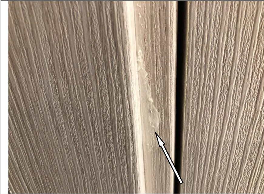
Фото №22. Загрязнения на коробке деревянного дверного блока в кладовке в квартире.
