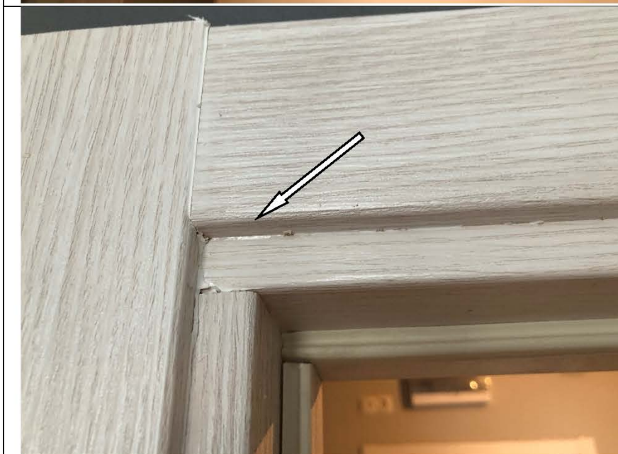
Фото №21. Загрязнения на коробке деревянного дверного блока в спальне в квартире.
