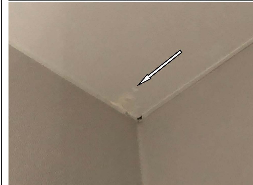
Фото №15. Загрязнения на натяжном потолке в кладовке в квартире.
