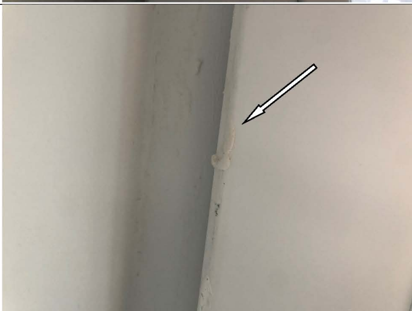
Фото №39. Загрязнения на профиле оконного блока ПВХ в спальне в квартире.
