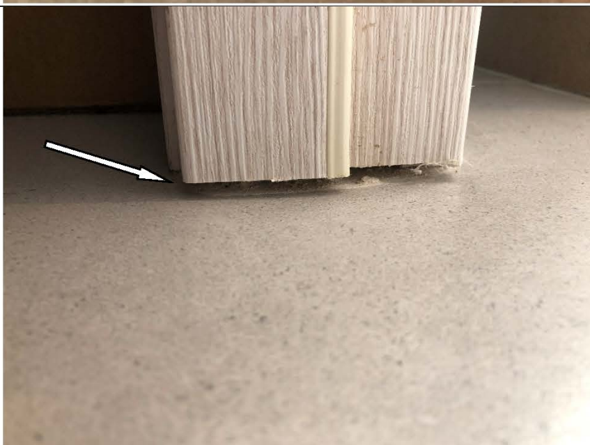
Фото №18. Не хватает наличника деревянного дверного блока до напольного покрытия в кладовке в квартире.
