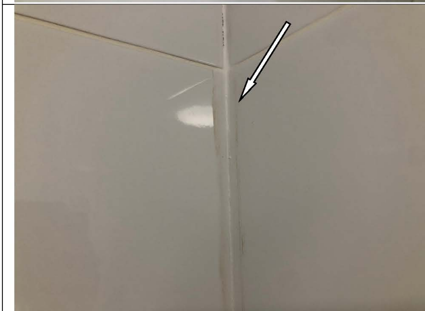
Фото №27. Неровный шов настенной керамической плитки в ванной комнате в квартире.
