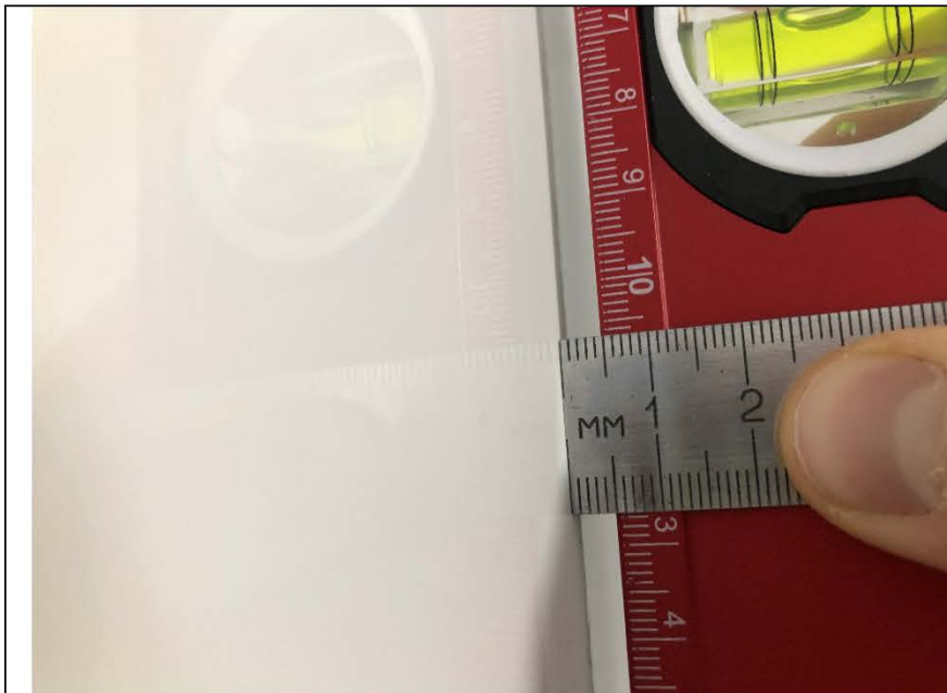
Фото №25. Измерение уровня стен ванной комнаты в квартире.
