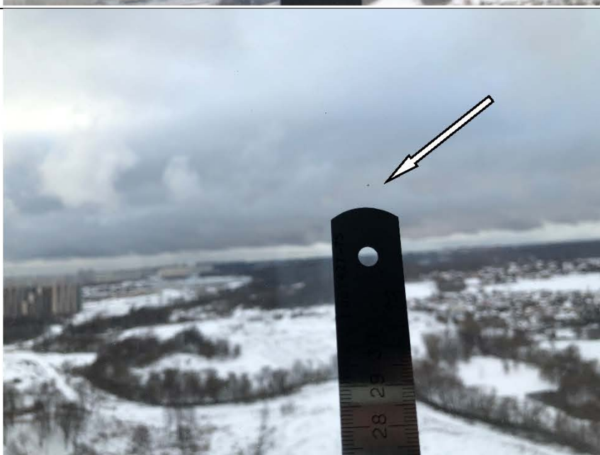
Фото №36. Окарины на стеклопакете оконного блока ПВХ в спальне в квартире.
