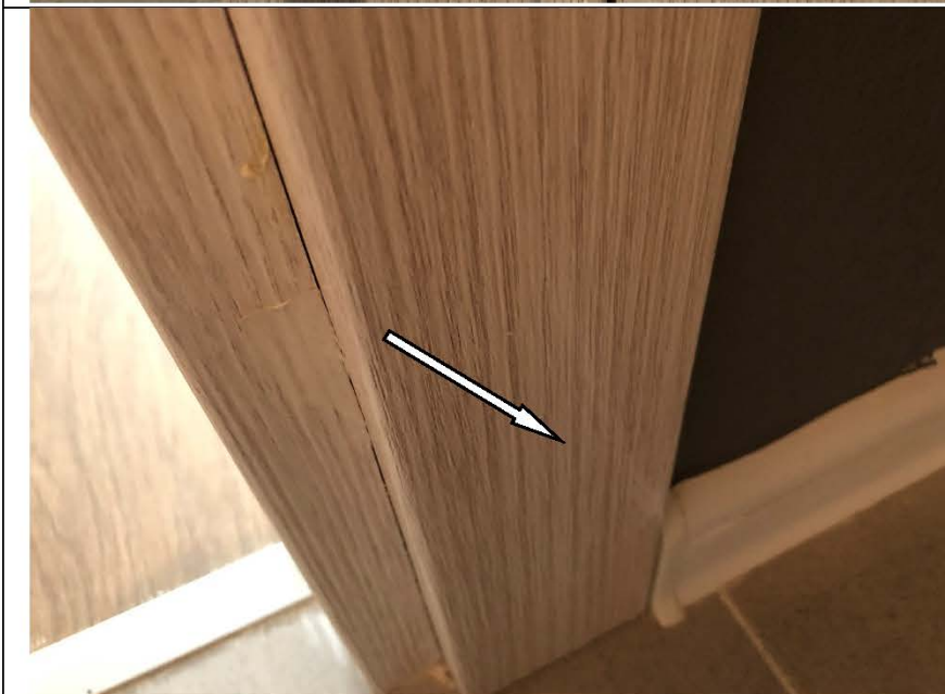
Фото №24. Загрязнения на наличнике деревянного дверного блока в спальне в квартире.
